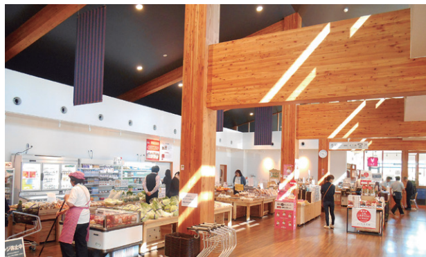
会津産の松を利用した大断面集成材の梁・柱
