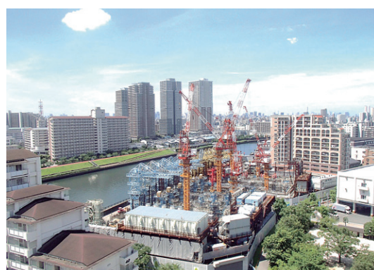
ケーソン沈設時の全景
