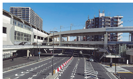
完了状況（京急蒲田駅付近）
