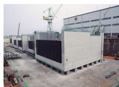
工場製作中の鋼殻(全8面)
