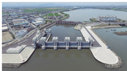
完成した日光川水閘門
