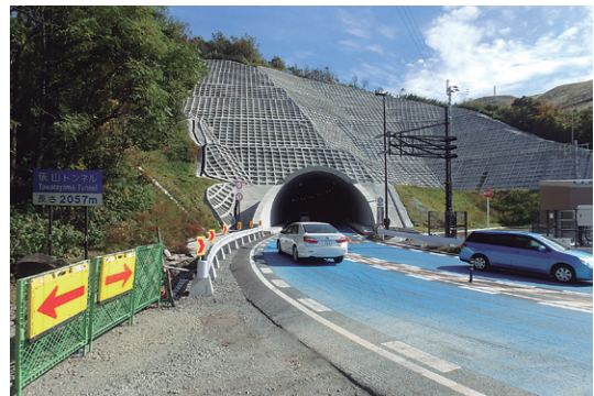
俵山トンネル熊本側坑口の通行状況
