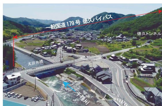
一般国道179号徳久バイパス完成写真
