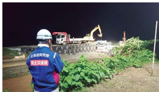
夜間作業（常呂川水系柴山沢川 平成28年8月23日撮影）
