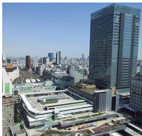
新宿跨線橋架け替え及び交通結節点整備により誕生したバスタ新宿
