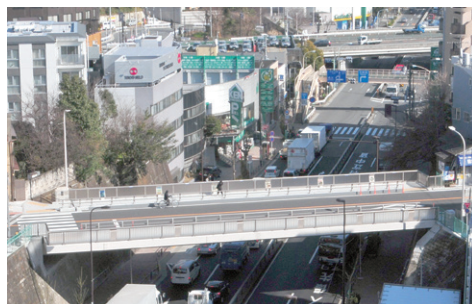
新馬込橋全景
