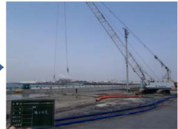
改良土打設状況
