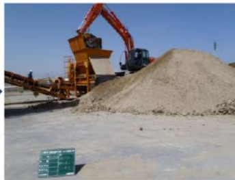
造粒土投入状況
