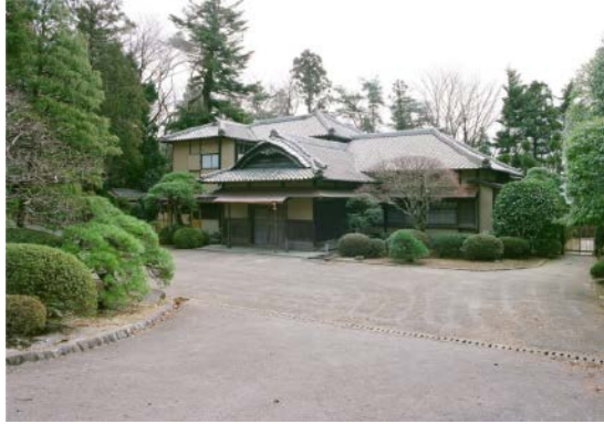
全景（茂ヶ崎庵復旧工事完了）
