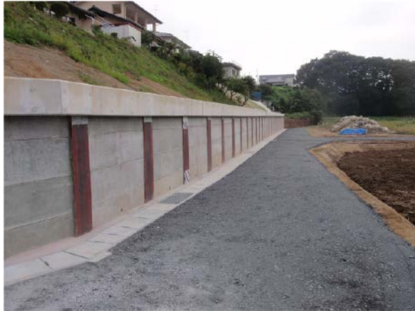
完成（抑止杭工法）
