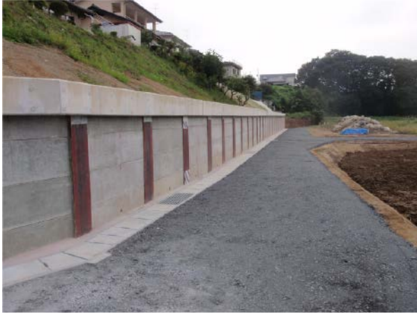
完成（抑止杭工法）
