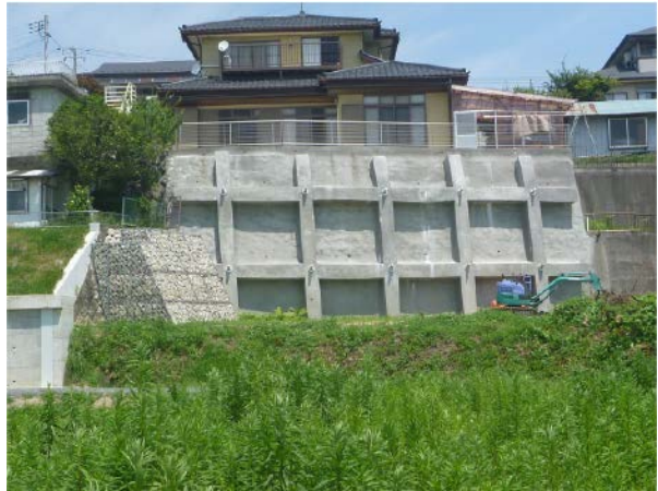
完成（グラウンドアンカー工法）
