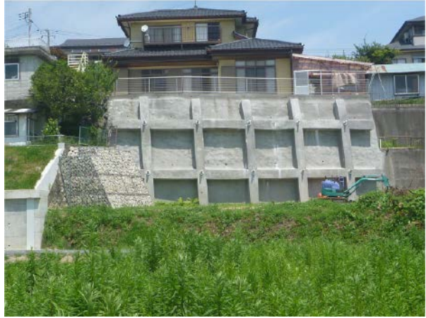
完成（グラウンドアンカー工法）
