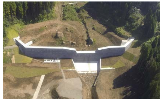
坂梨砂防堰堤（砂防ソイルセメント）
