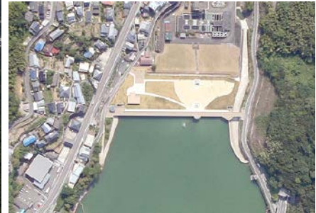
本河内高部ダム（上流側より）
