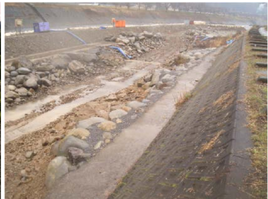
根固工（巨石）施工状況
