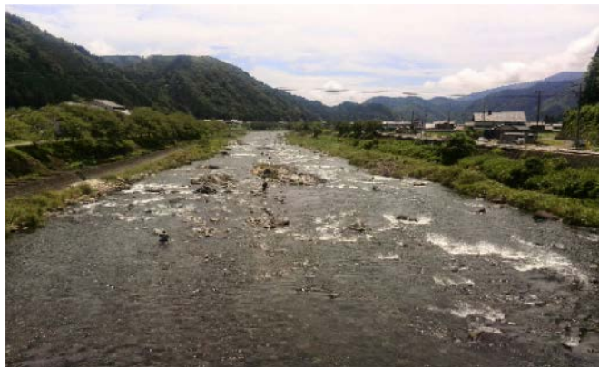
工事完了後写真（上流より平成26年7月20日撮影）
