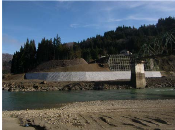
復旧後の牧ノ戸地区
