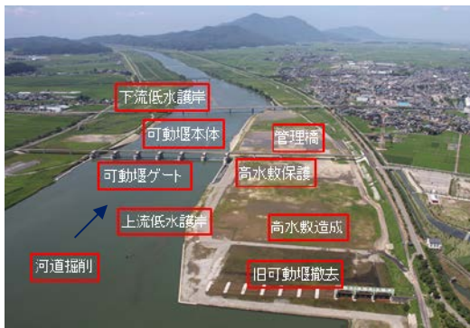
竣工後の大河津可動堰（H26.7）
