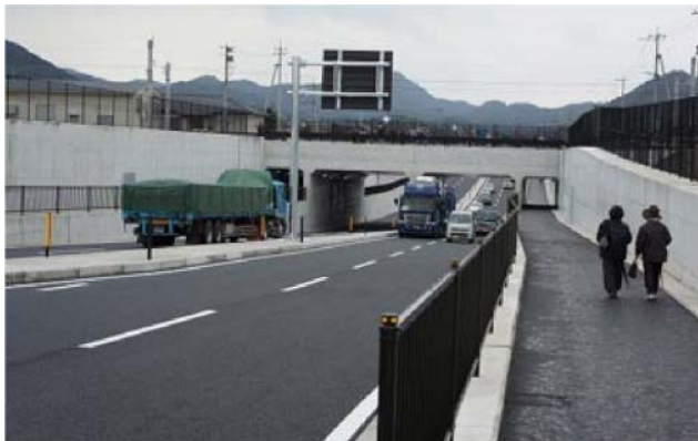
完成後（日向バイパスJRアンダー部分付近）
