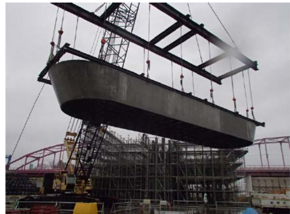
REED工法による橋脚施工
