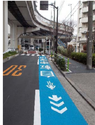
整備後 ゼブラゾーン廃止・自転車ナビマーク設置
