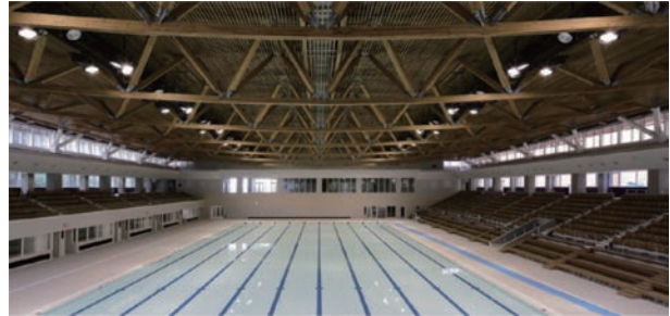
屋内50mプール及びハイブリッド構造の屋根架構
