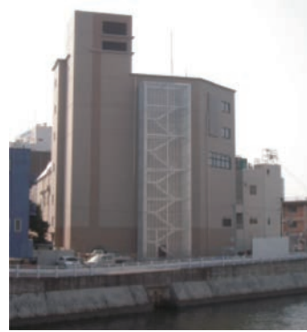
博多駅北ポンプ場
