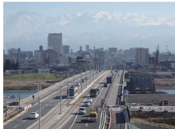
富山大橋（正面写真）
