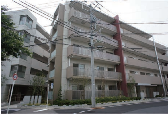
防災施設建築物 耐火建築物への建替えによる不燃化・耐震化
