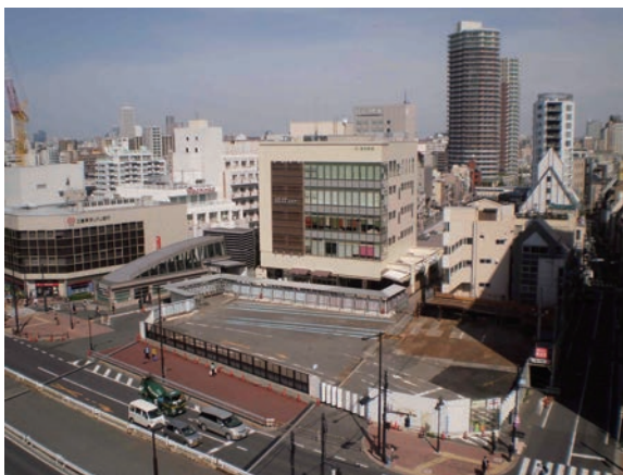
東中野駅西口自由通路（整備後） 人工地盤を張り、駅ビルと自由通路が一体的に整備され、駅前広場までの導線が確保された。
