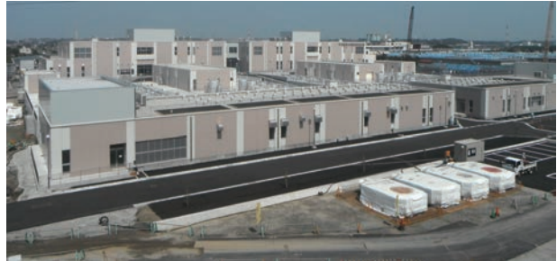
高度浄水施設（三期）完成
