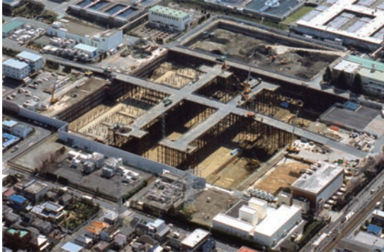
高度浄水施設（三期）築造着手時全景
