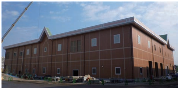
西日暮里系ポンプ室完成写真
