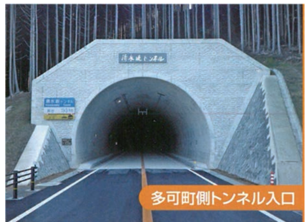
清水坂トンネル入口
