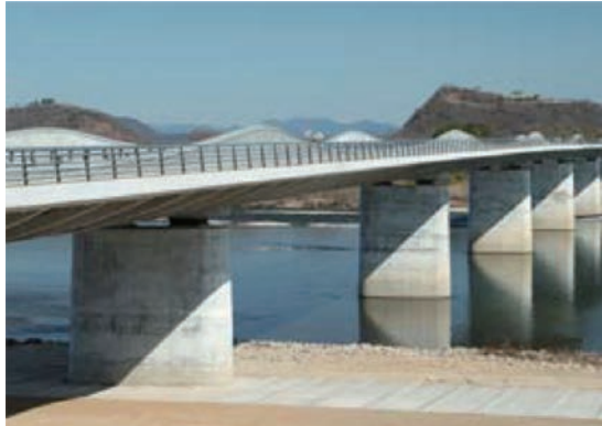
全景（堤防道路より）
