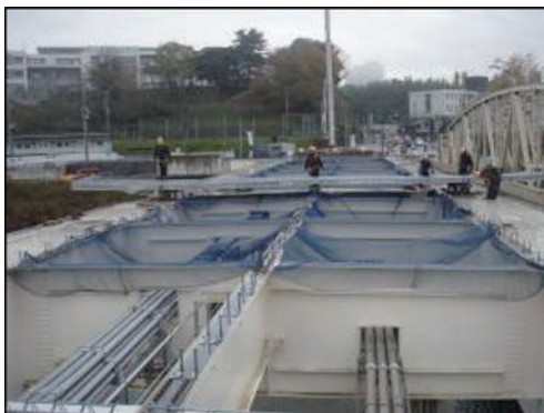
床板縦送り架設状況
