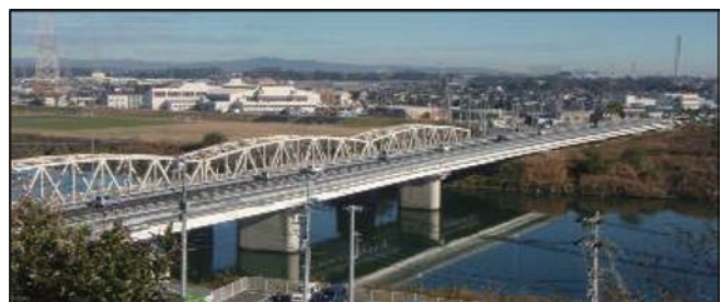
右岸から左岸を望む
