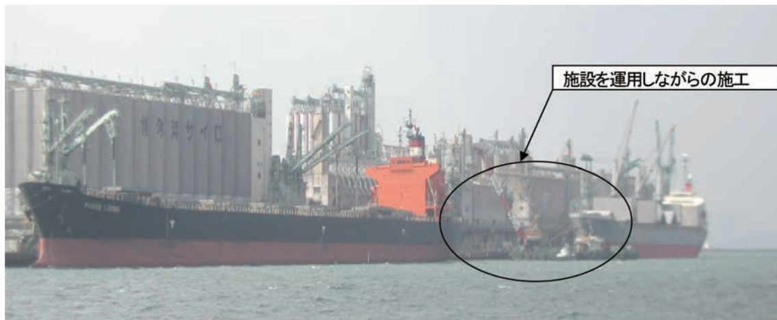
荷役作業中の船舶と施工中の工事
