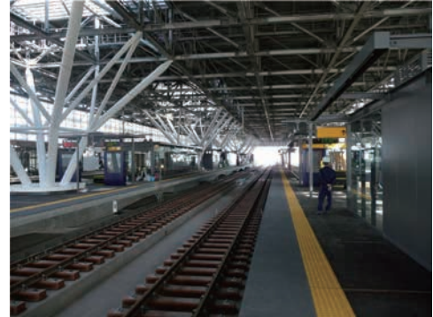
四又柱で支えられた駅舎
