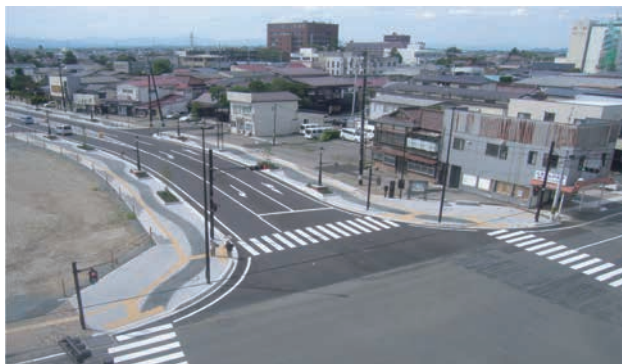
完成状況 流れをイメージした歩道部の洗い出し模様
