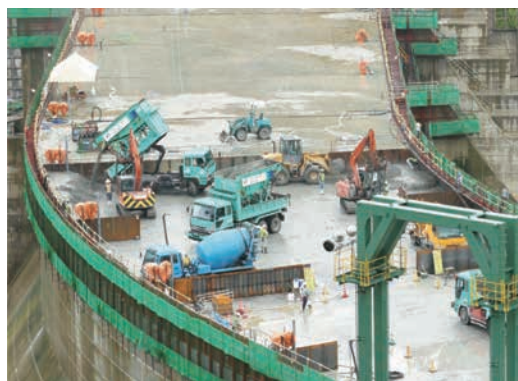
ELCM工法(拡張レア工法)
