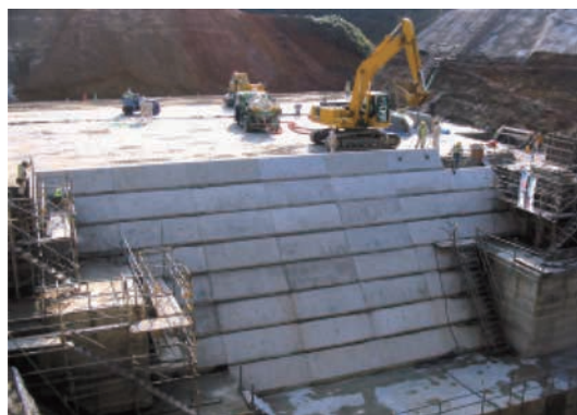
沢処理工の台形CSGダム
