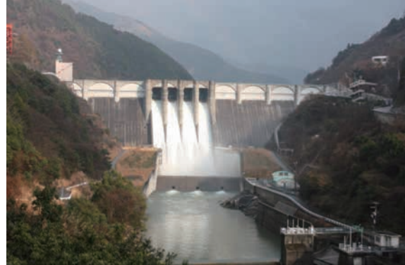
大滝ダム下流から
