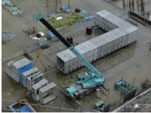
プレキャスト通廊施工状況
