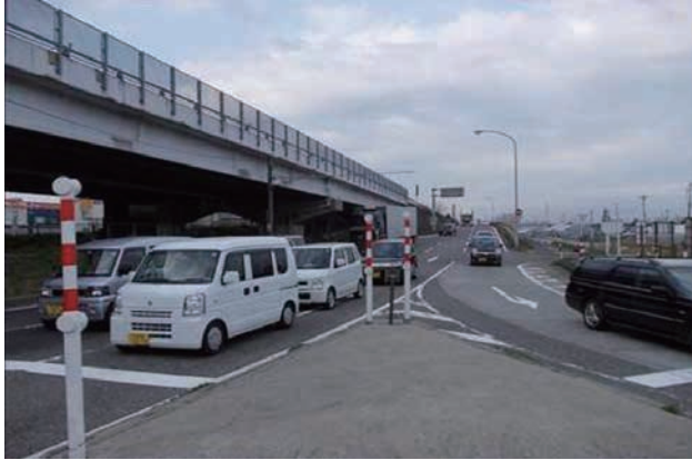
整備後の竹尾ICオフランプ
