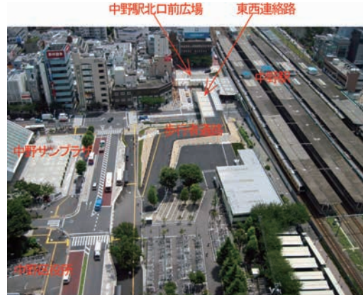
東西連絡路、北口駅前広場全景 駅から信号無しで繋がった歩行者空間
