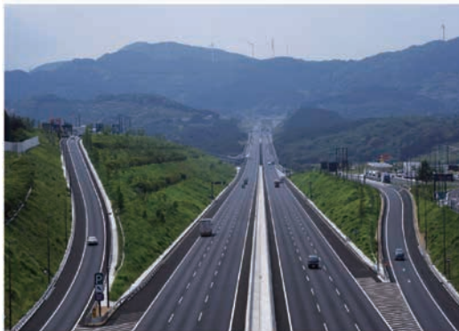
開通後の新東名(浜松SA付近)
