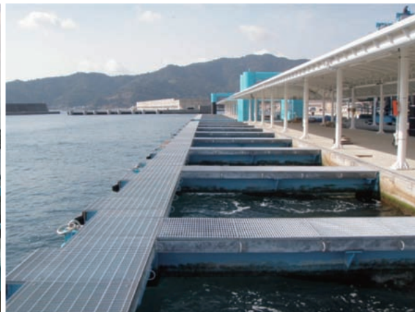
歩廊及び生け簀部分
