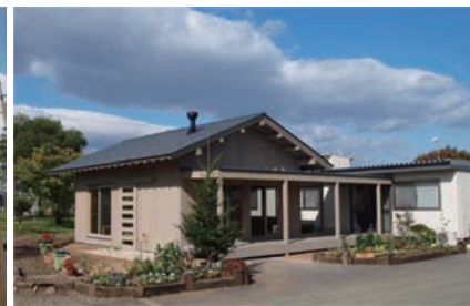
「みんなの家」竣工写真
