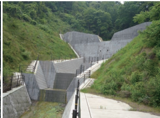
完成後4年経過し植生が回復した宮園3号砂防堰堤
