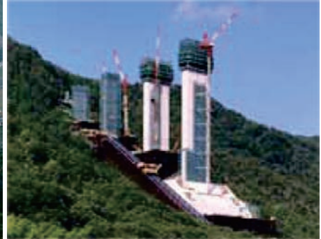
作業構台とインクライン設備
