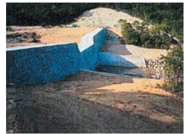
松ヶ谷川砂防堰堤
