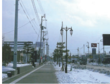
無散水消雪歩道
