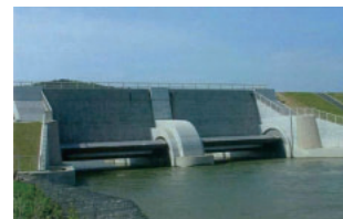
脇波水門完成
