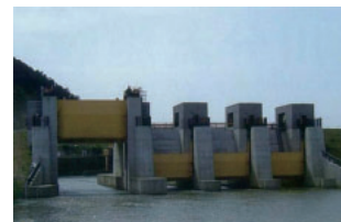
脇谷水門完成
