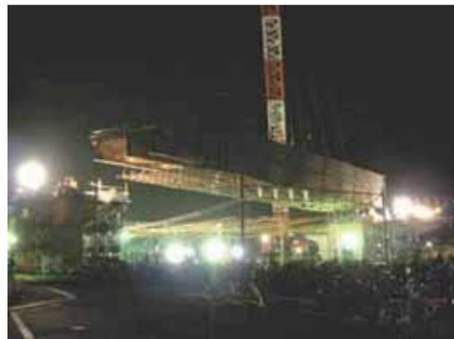
世界最大級大型クレーン（1,200t吊り）による桁架設状況
