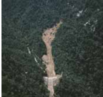
1号えん堤完成
