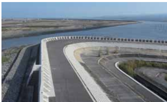
完成した海岸堤防
