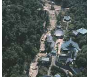
2号えん堤と溪流保全工の完成
