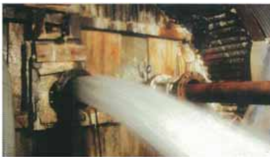
大量湧水の発生状況
