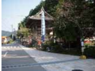
修景整備工事完成状況
