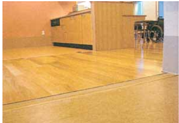
ユニット内部
