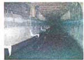
雨水渠内敷設状況
