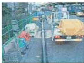
地上より雨水渠内へ 送り込み
