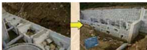
隠れ家となる空隙の確保(巣穴マンホール・巣穴ブロックの設置)
