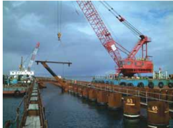
ストラット部材仮設
