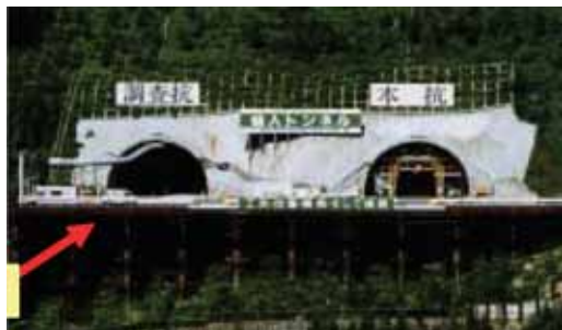
トンネル坑口部
