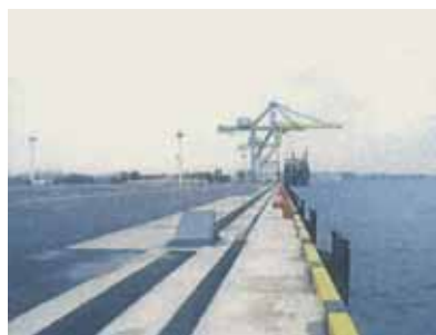
完成した10号岸壁
