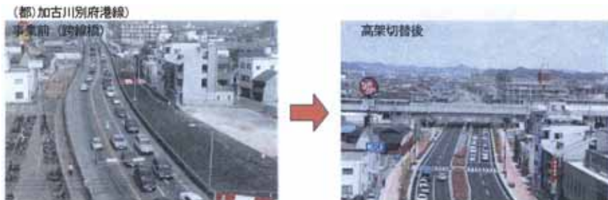
交差道路の整備前後
