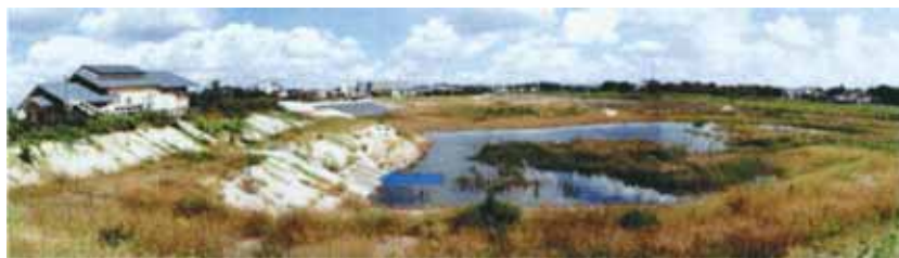
調節池の全景（排水機場から左側の大柏川に排水する）
