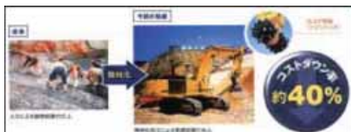
機械化施工による基礎岩盤仕上げの効率化
