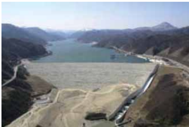
下流側から堤体を望む
