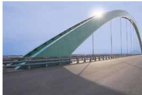
吊り材にケーブルを使用（主径間部）
